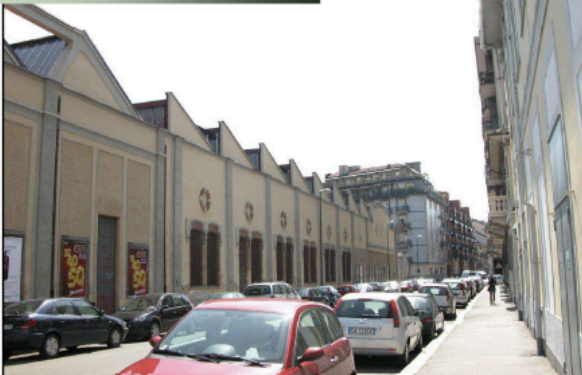
Via Revello vista da via Frejus – il fronte del "Magazzino centrale"
