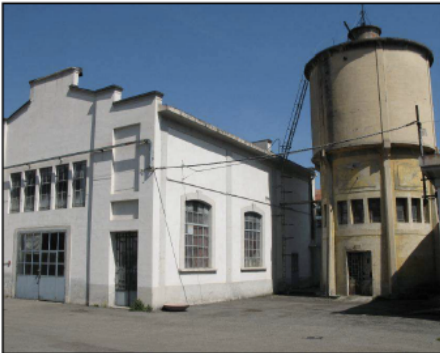
Cortile di servizio e fronte interno del magazzino
