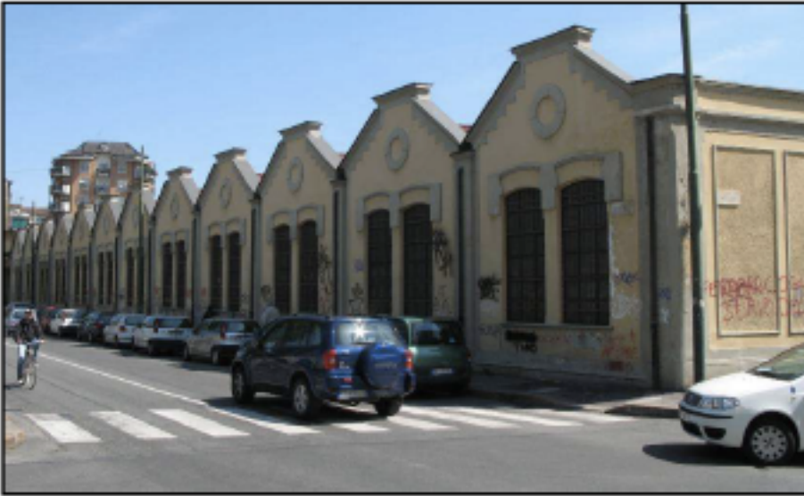
Via Frejus angolo via Revello: facciata esterna del "Magazzino pezzi finiti"
