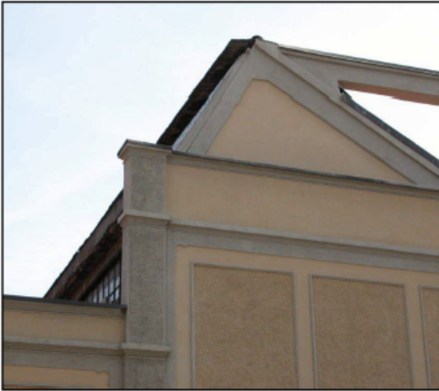
Particolare del muro esterno su via Revello: la capriata dell'edificio "Carroponte"
