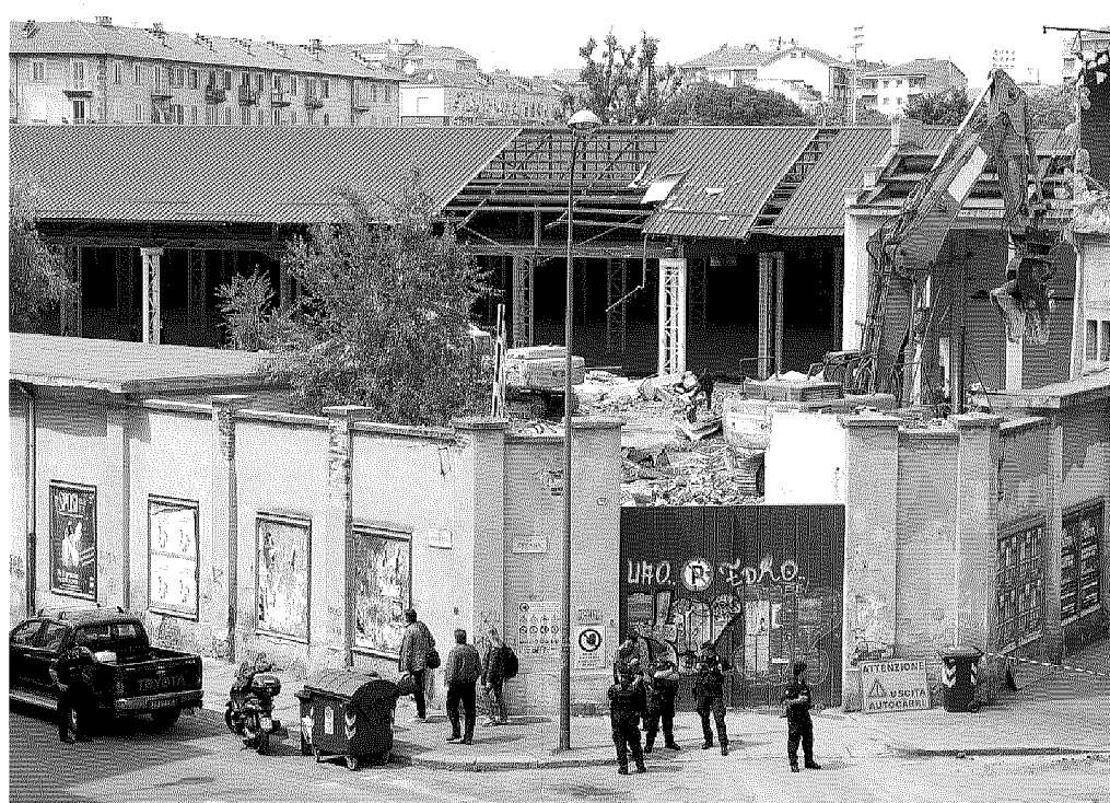
La demolizione della ex Diatto avviata ieri mattina in via Frejus
